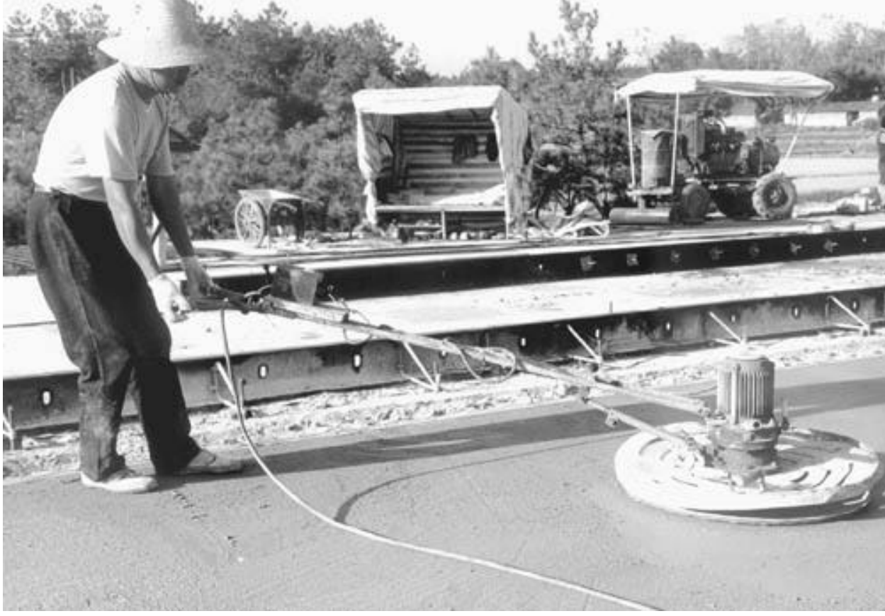
横贯我国东西运输大动脉的高等级公路——沪（上海）蓉（成都）高速公路安徽段，目前正在加紧施工，路面铺设工程已完成95%以上。图为铁四局建设者在抓浆路面施工。徐宝亮摄
